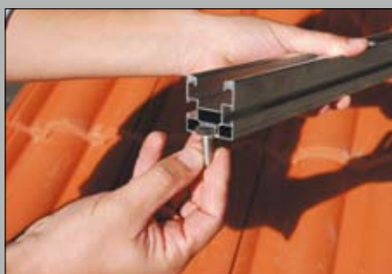
2 - Innesto le viti nel profilo Solar-Plus
