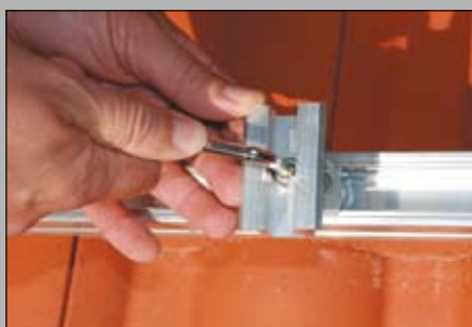
5 - Innesto i morsetti PMF e PMC
