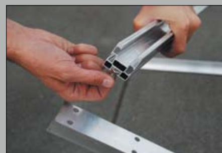
3 - Innesto le viti nel profilo Solar-Plus
