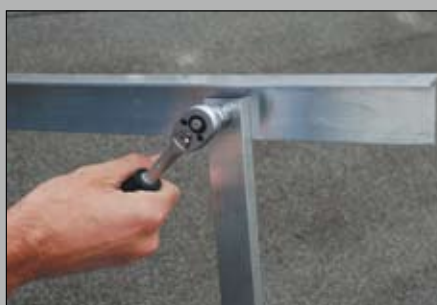
2 - Fisso la posizione del telaio STF
