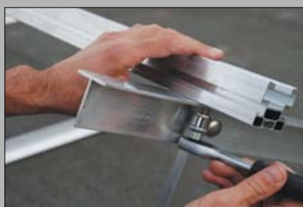
4 - Fisso il profilo Solar-Plus al telaio
